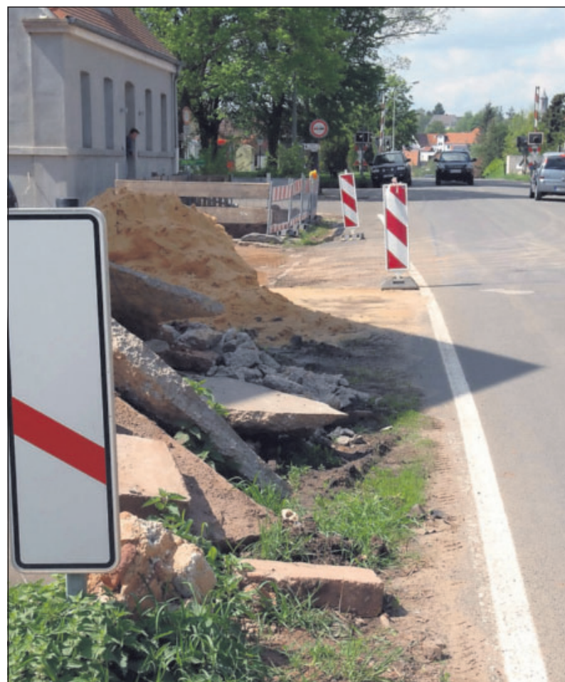
Gegenwärtig ruht der Straßenausbau in der Bahnhofstraße, nachdem die beauftragte Firma, die inzwischen an ein anderes Unternehmen veräußert wurde, ihre Arbeit eingestellt hat. FOTO: STEPAN
