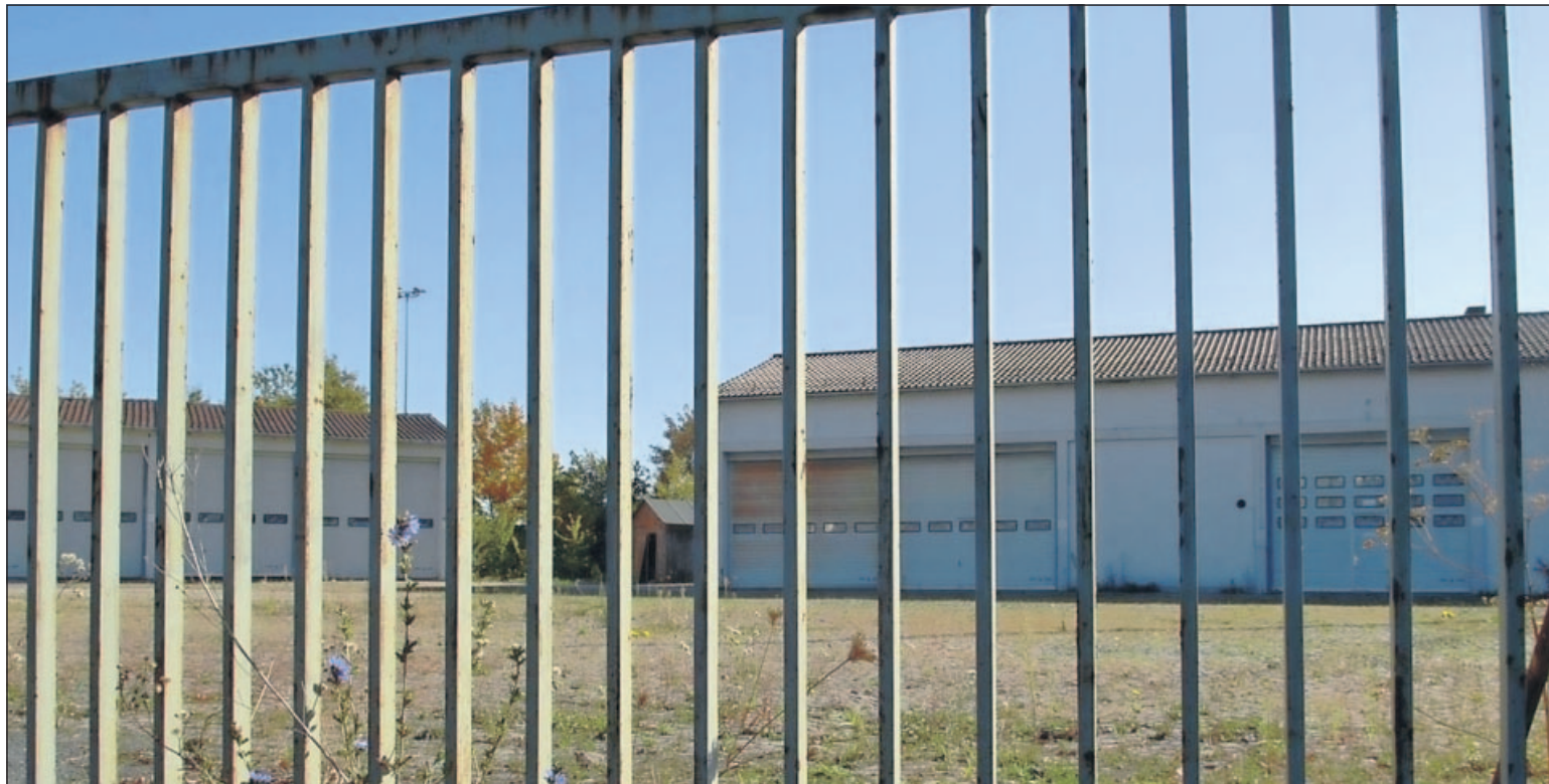
So verschlossen, wie das geplante Erweiterungsgelände der früheren Straßenmeisterei sich präsentiert, wurde bisher die „Sache Bürogebäude“ behandelt. FOTO: STEPAN
